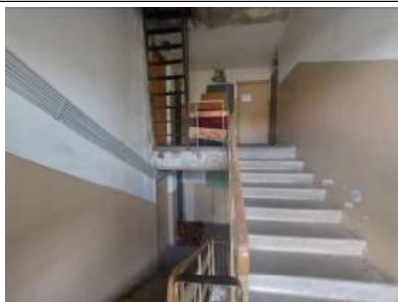
3.stāva kāpņu telpa
